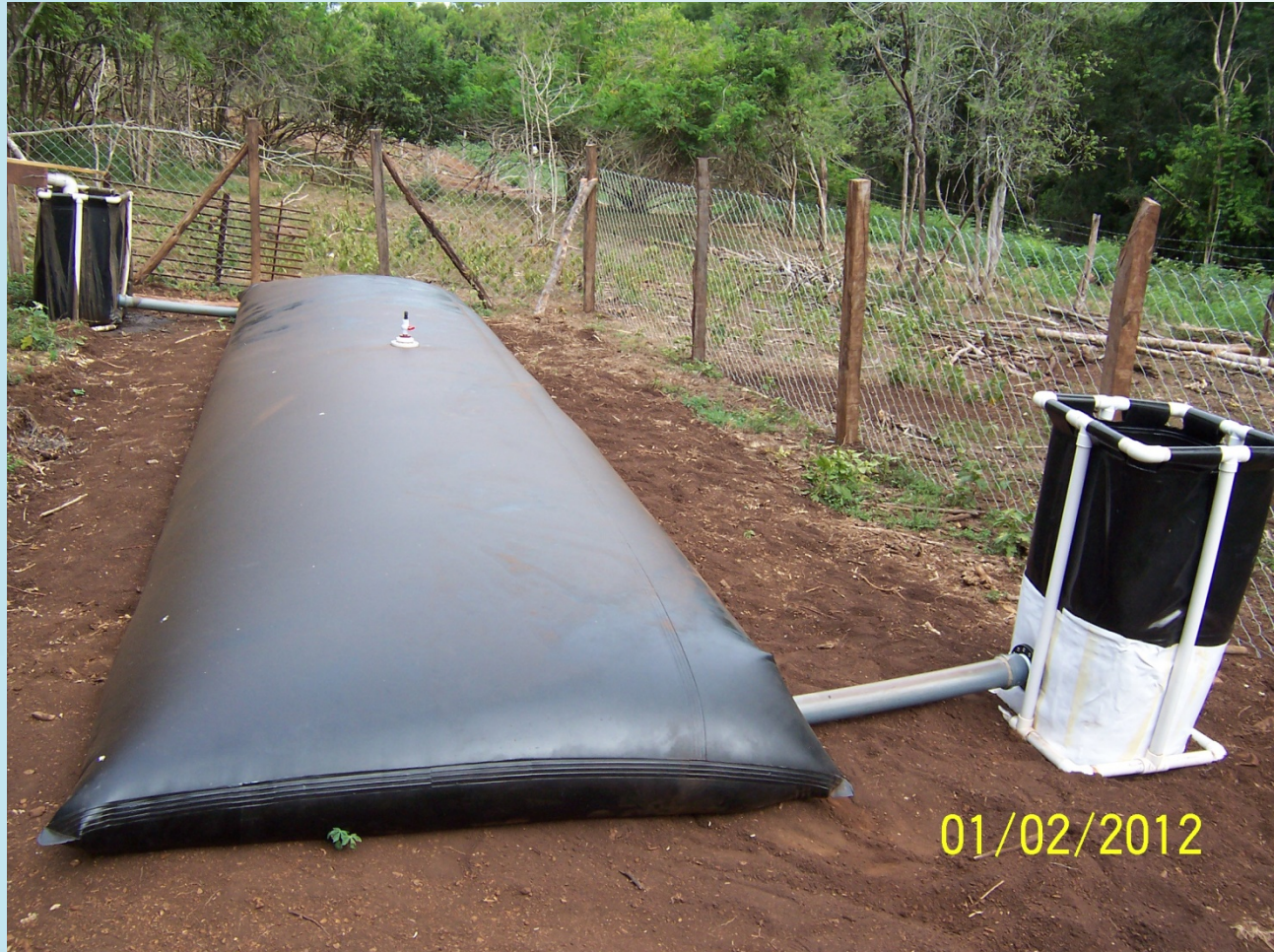
Fotografía: Digestor flexible Energías del Sol S.A. Tamaño: 5 metros cúbicos.
